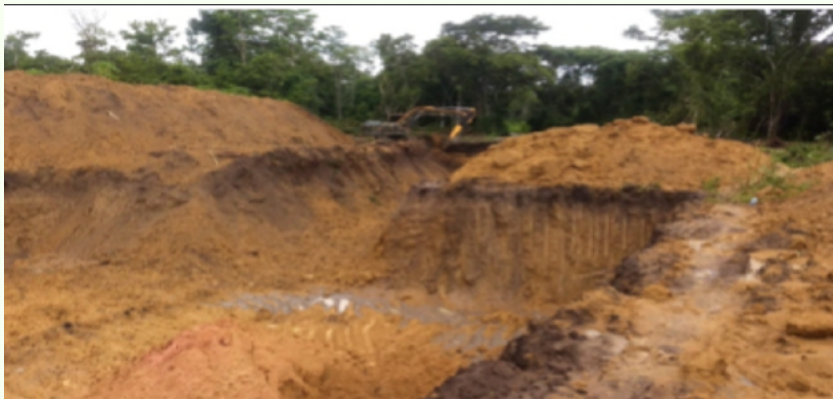
Image 2 - Des trous creusés par des rétrocaveuses hydrauliques qui creusent les berges des rivières à la recherche d'or et détruisent les forêts riveraines.
